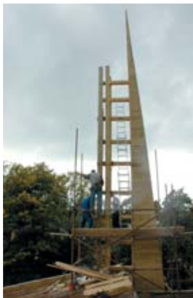
Bednění a montáž konstrukce věže
