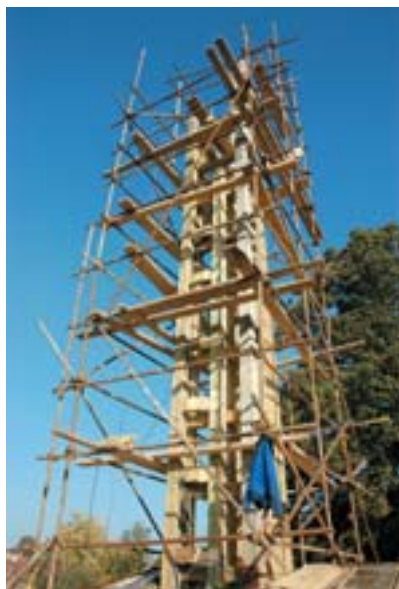
Bednění a montáž konstrukce věže
