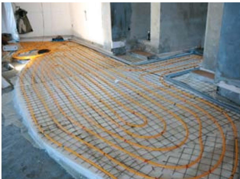
Pokládání podlahového topení
