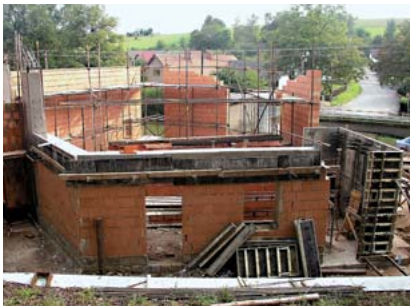
Dokončování nosných zdí a pilířů
