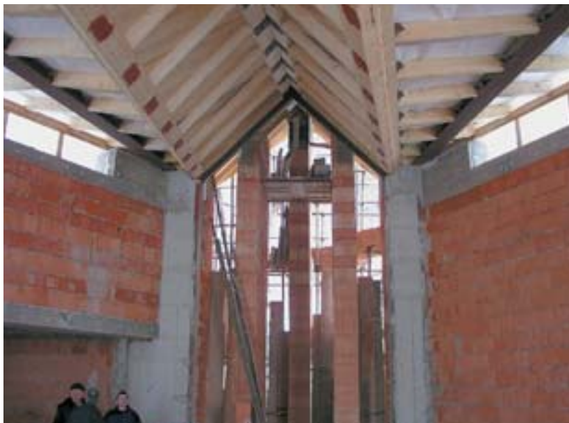
Interiér kostela v průběhu hrubé stavby
