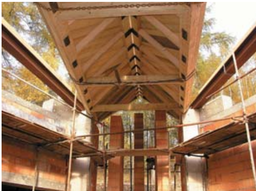
Usazení krovu na hrubou stavbu
