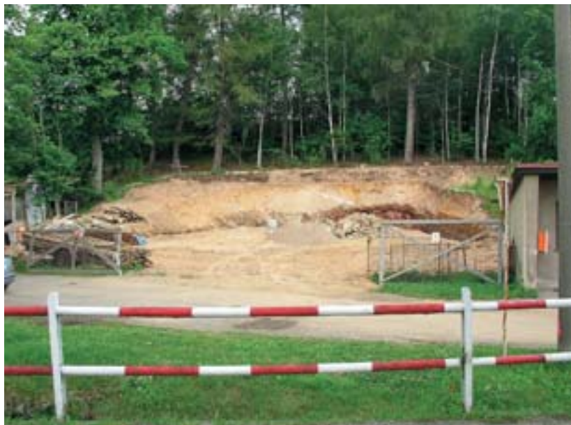
Úprava terénu před stavbou kostela
