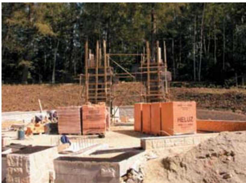
Kamenný sokl kostela a zahájení zdění zdiva
