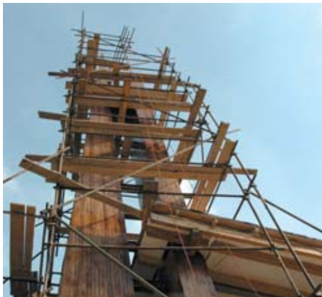
Bednění a montáž konstrukce věže
