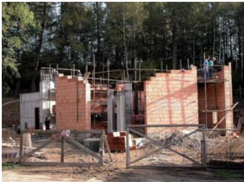
Stavba nosných zdí a betonáž základů kostela
